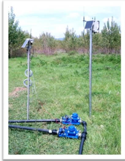
Εγκατάσταση ηλεκτροβανών
